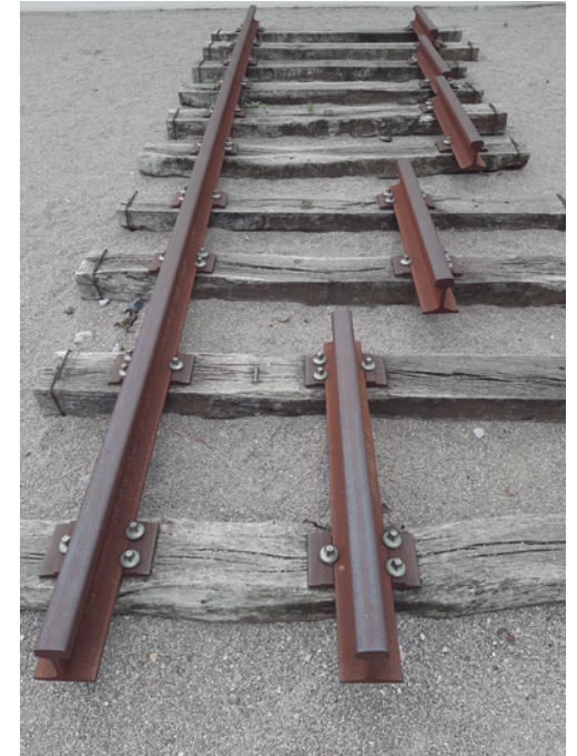
Model d’amplades de via al Museu del Ferrocarril (Vilanova i la Geltrú).
